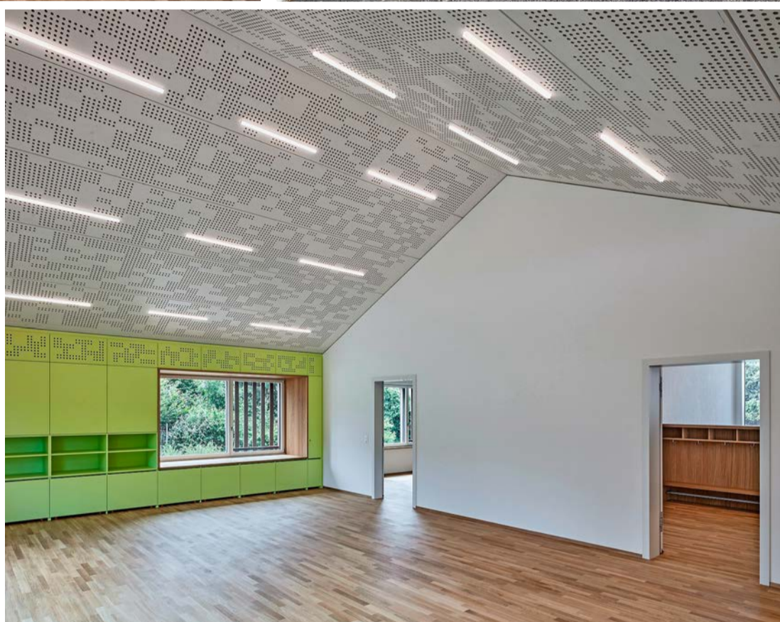
Kindergartenraum mit Stauraummöbeln und Fensternische: Ein besonderer Hingucker ist die weisse Akustikdecke mit dem gelaserten Lochmuster
